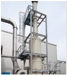
排ガス洗浄装置（スクラバー）
